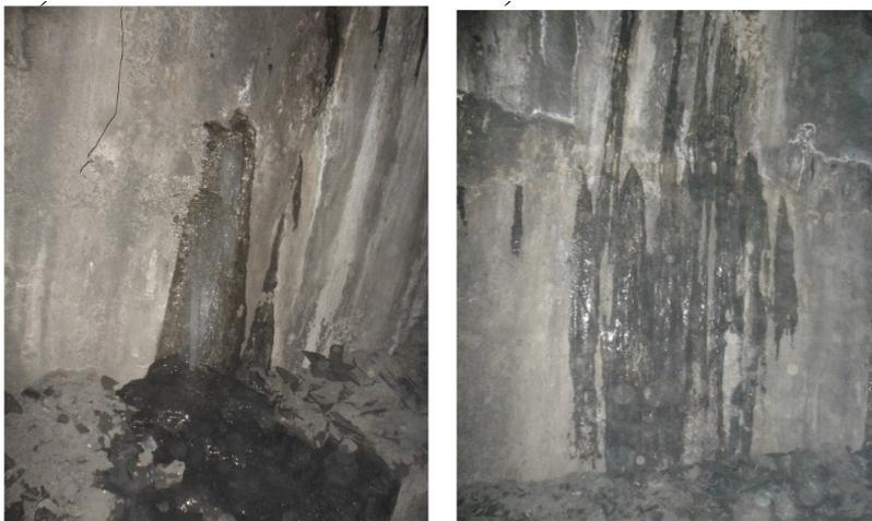
Рисунок 2 – Наледь-образование в обделке тоннеля «Истиклол»
